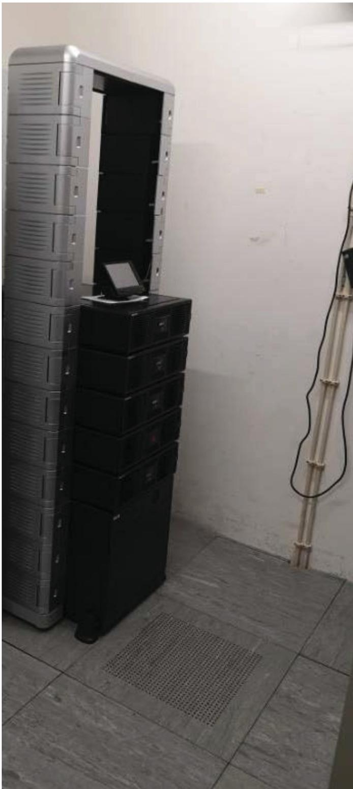
*Fotografia 2- UPS existente (a substituir)*
