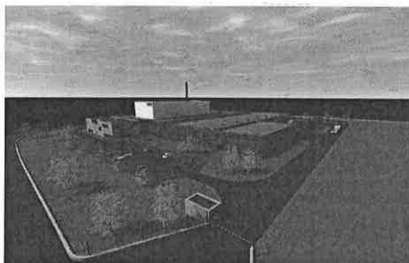
CIVTRHI - Centro Integrado de Valorização e Tratamento de Resíduos Hospitalares e Industriais
