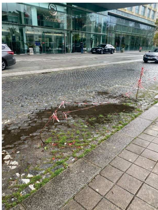
Figura 1 – Deformações, irregularidades e desgaste da faixa de rodagem.
