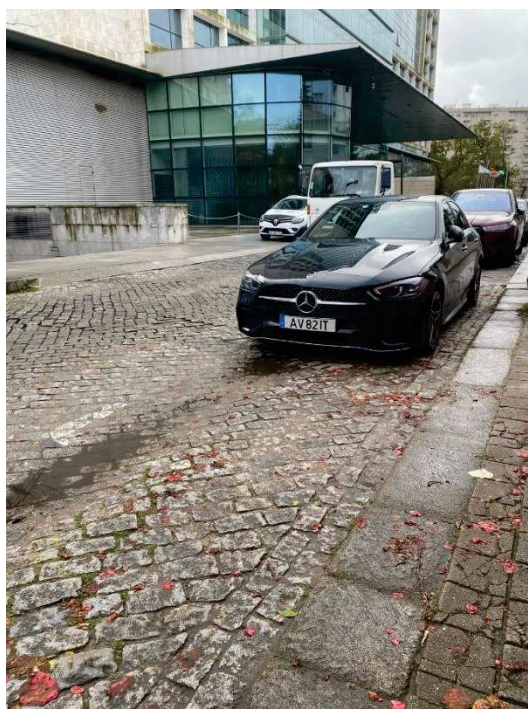
Figura 1 – Deformações, irregularidades e desgaste da faixa de rodagem.
