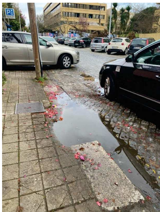
Figura 1 – Deformações, irregularidades e desgaste da faixa de rodagem.
