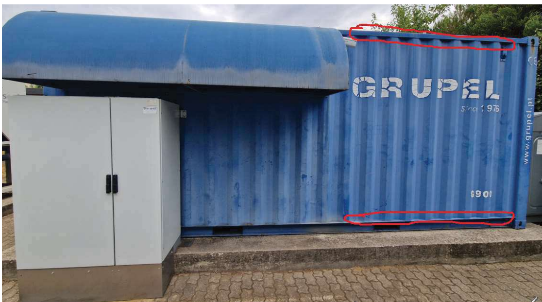
Fotografia 5- Pontos válidos de fixação
