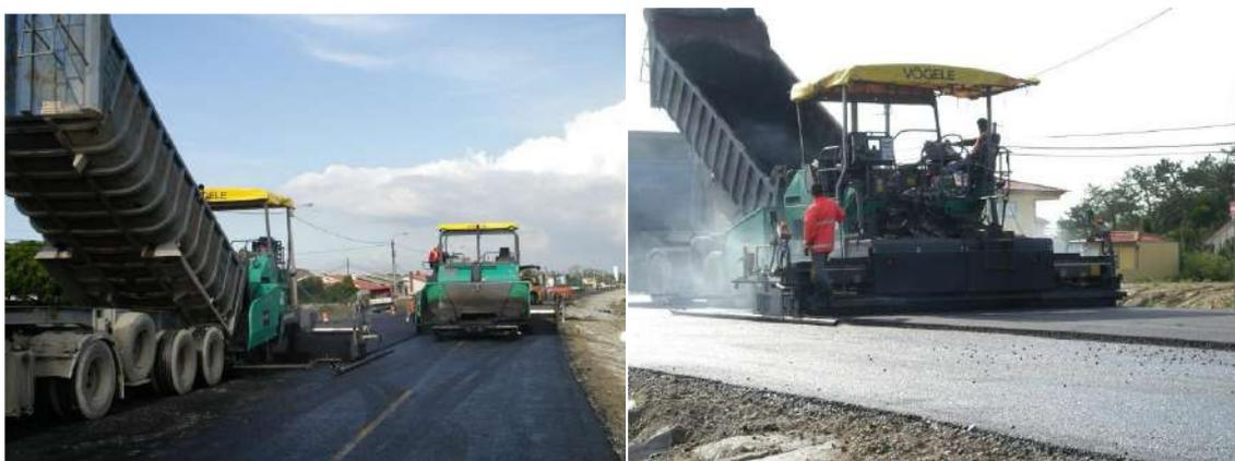
**Figura 15 - Equipamento de aplicação de pavimentação em mistura betuminosa**
