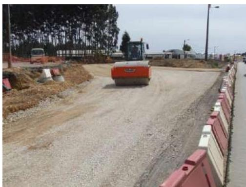
**Figura 10 – Exemplos de equipamento para espalhamento e compactação de camadas de base**
