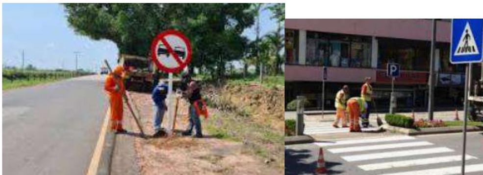
**Figura 16 - Equipa de colocação de sinalização vertical**
